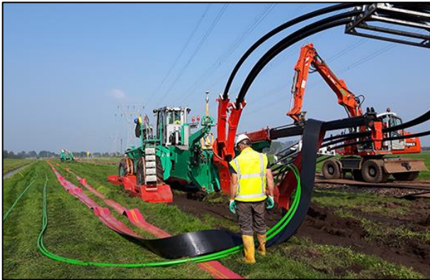
Verlegung von unterirdischen 150 kV Hochspannungsleitungen im Dreiecksverband
