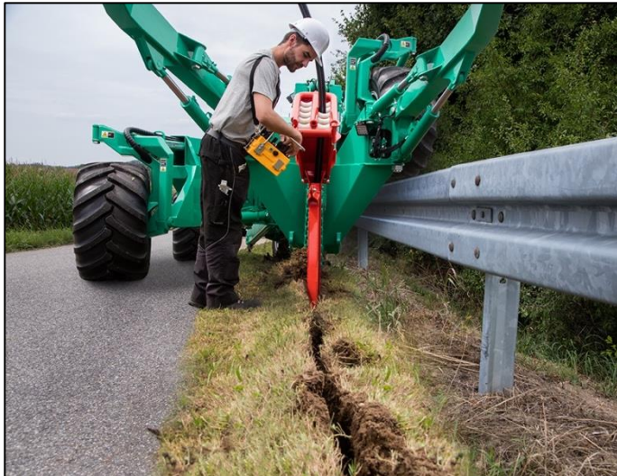
Bild 1. Der FOECK Verlegepflug FSP 6 erlaubt die Verlegung direkt an der Grundstücksgrenze. Die Bedienung erfolgt mit der Funkfernbedienung FRC 2-1
