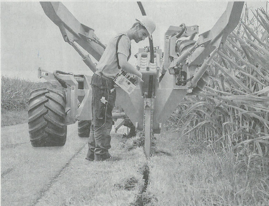
Der Foeck Verlegepflug FSP 6 erlaubt die Verlegung direkt an der Grundstücksgrenze. Die Bedienung erfolgt mit der Funkfernbedienung FRC 2-1. FOTO: FOCKE
