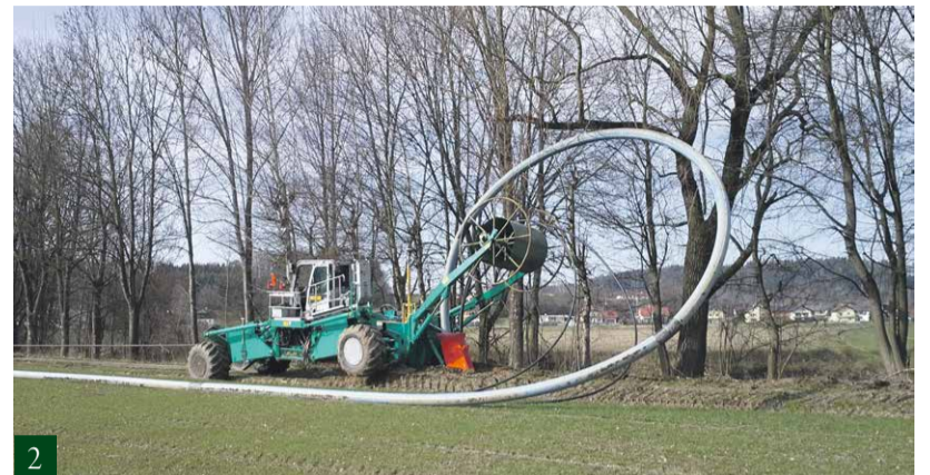
2: Verlegung eines Wasserrohres mit Durchmesser 225 Millimeter für WVA Antheering in Salzburg. | 3: Verlegung einer Pipeline mit PP-Schutzmantel mit einem Durchmesser von 225 Millimeter in Schwanenstadt (OÖ).
