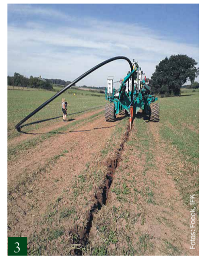
2: Verlegung eines Wasserrohres mit Durchmesser 225 Millimeter für WVA Antheering in Salzburg. | 3: Verlegung einer Pipeline mit PP-Schutzmantel mit einem Durchmesser von 225 Millimeter in Schwanenstadt (OÖ).
