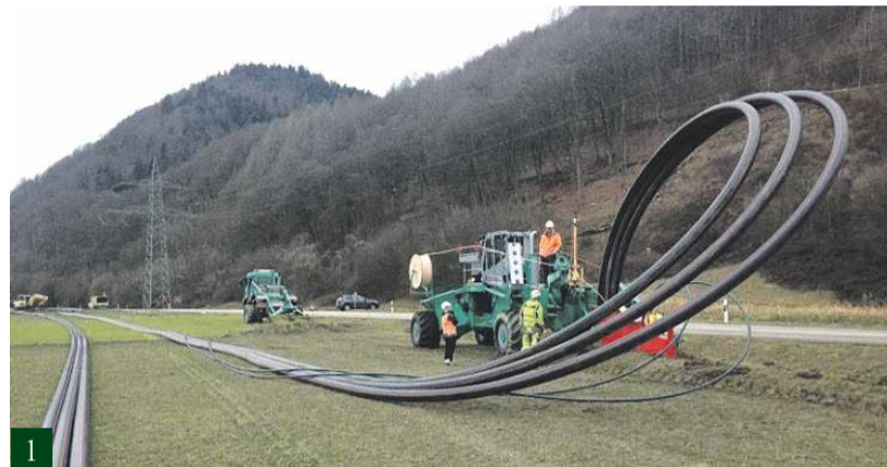
1: Ansicht der Verlegung beim Projekt Jochenstein, vorne das Seilwindenzugfahrzeug dahinter der gezogene Kabelpflug. Man sieht deutlich, dass viele Rohre gleichzeitig in das Erdreich eingebracht werden und nur eine geringe Nacharbeit erforderlich ist.
