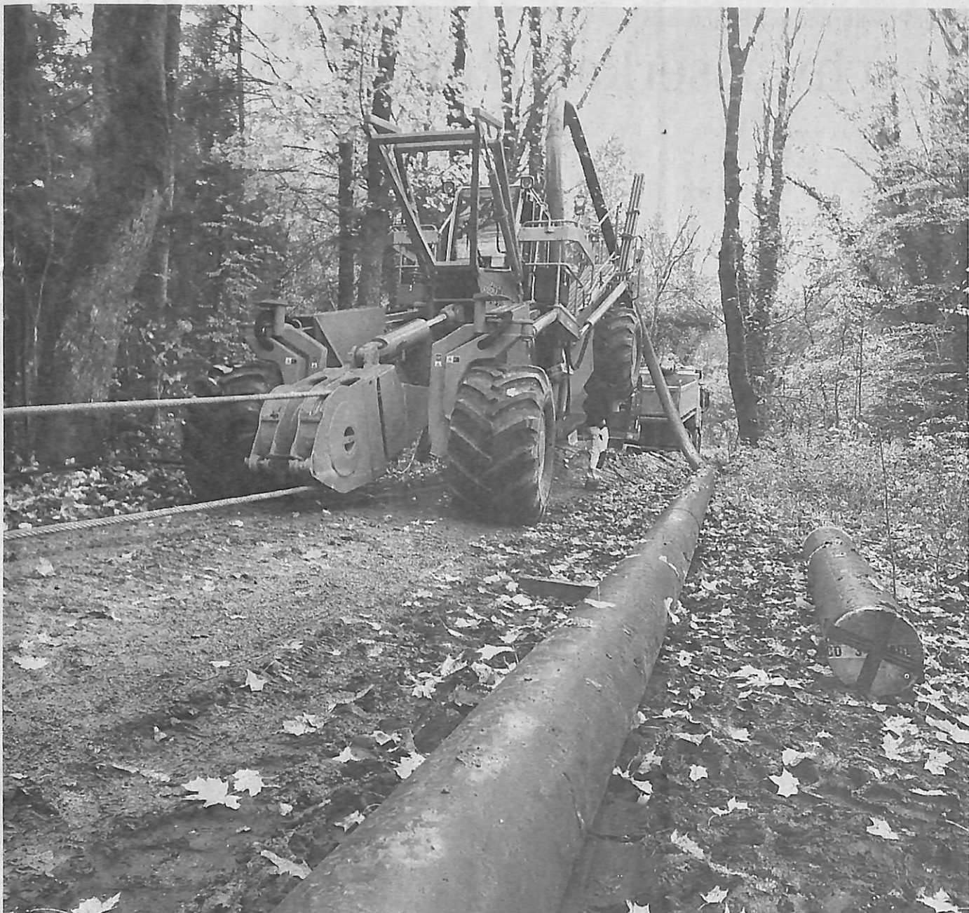
Die Wasserleitungen, die sauberes Trinkwasser bringen, wurden mit dem Focke-Verlegeflugsystem schnell und ohne Schädigung des Waldes verlegt. FOTO: FÖCKERSPERGER
